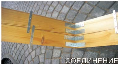
ПОДВОД КРЕПЕЖА ПОД ПРЕДЫДУЩУЮ ДОСКУ
